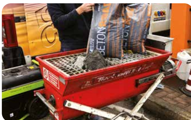
2A. Priprava BetonRoad z vijačnim mešalnikom.
