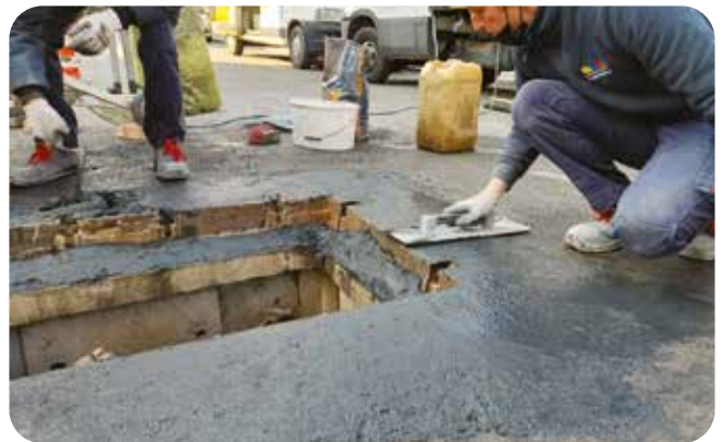
7 Zaključna obdelava z BetonRoad.
