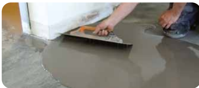
Izravnava novih betonskih plošč pri sistemu utrditve stropov.
