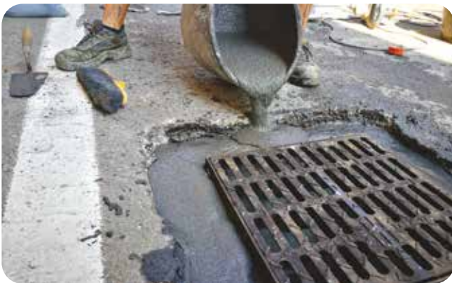
6b. Zapolnitev na zunanji strani s tekočim BetonRoad.
